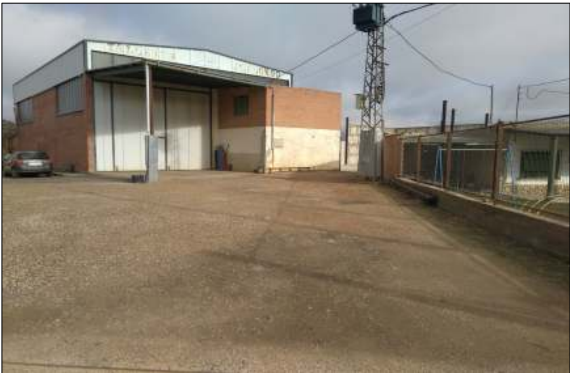
Figura 11. Edificación existente en el ámbito de aplicación (2).
